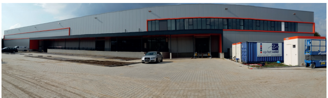
Außenansicht der Anlage
